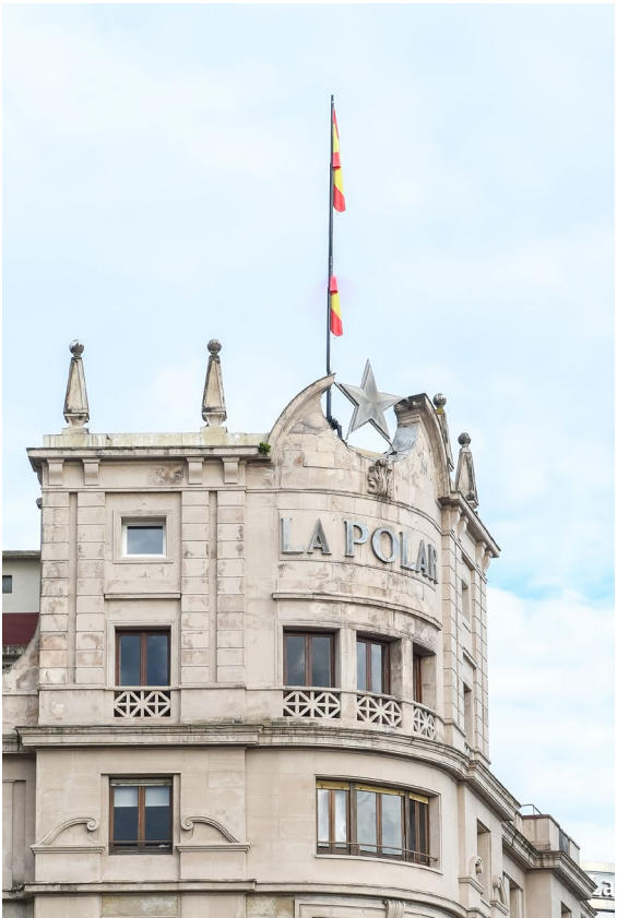
EDIFICIO LA POLAR. CALVO SOTELO | LA POLAR BUILDING. CALLE CALVO SOTELO
