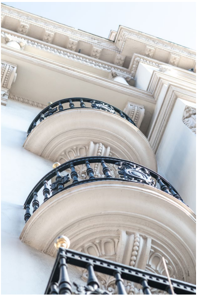
EDIFICIO VITALICIO. CALLE CASTELAR | VITALICIO BUILDING. CALLE CASTELAR
